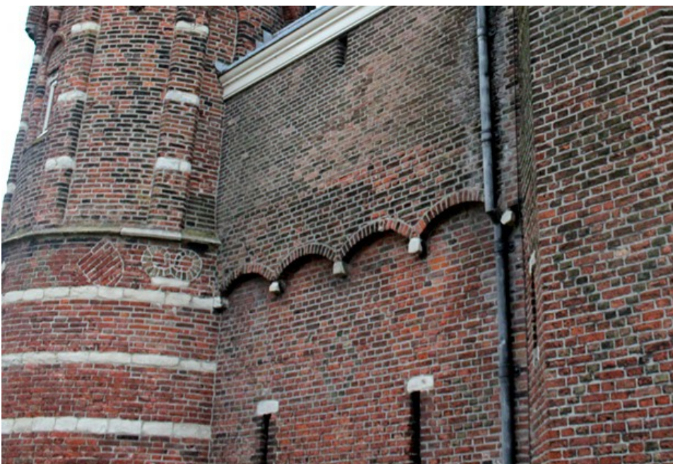
De Amsterdamse Poort te Haarlem. In de ronde toren links zien we de bekende ingemetselde heraldische symbolen met daartussen een maalkruis. Onder in het middenvlak een ruit en een maalkruis. In de toren rechts een groot maalkruis.
